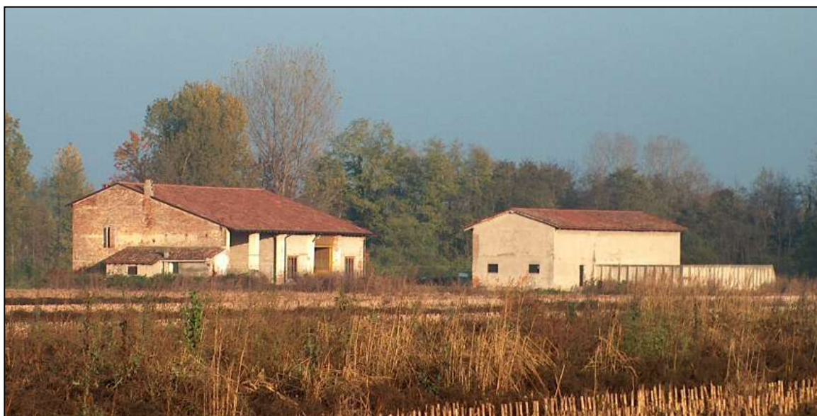
Foto 2 – la Cascina ripresa da Sud – Ovest
